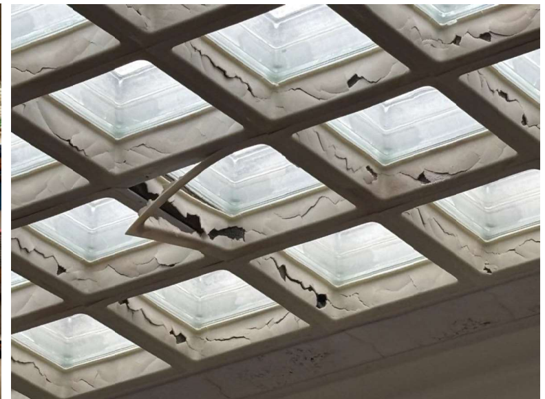
アトリウムガラスブロック現況
