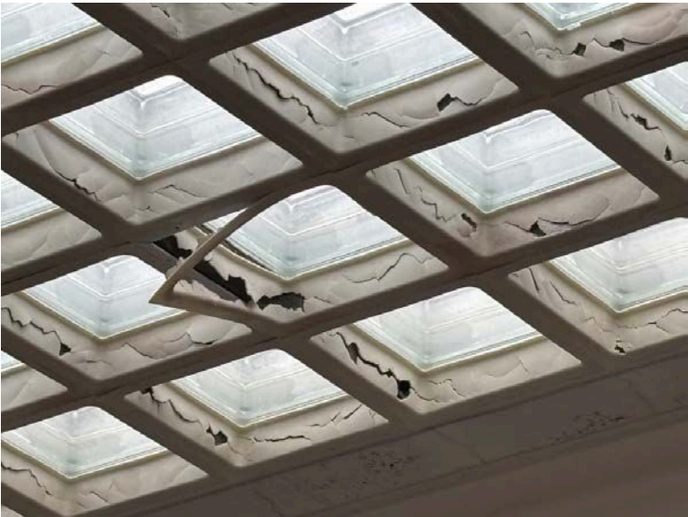
アトリウムガラスブロック現況
