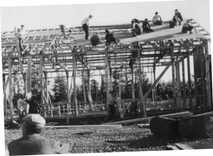
大栄(鶴之巣)小学校建設工事 (昭和23年撮影)
