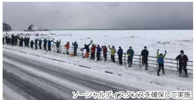
除雪作業の様子
