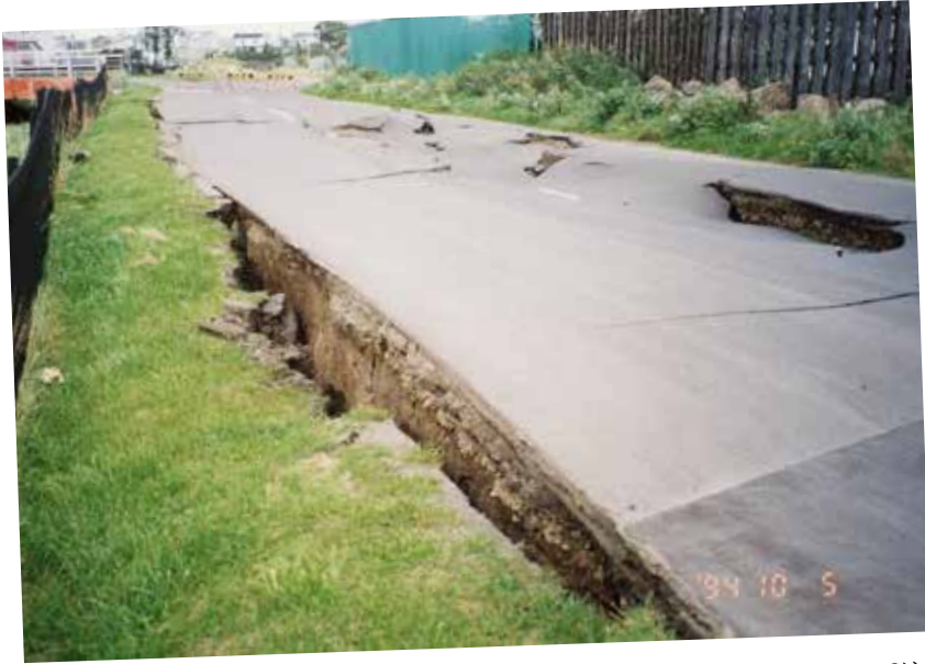
地震で陥没した斜里町内の道路(1994年10月撮影)
