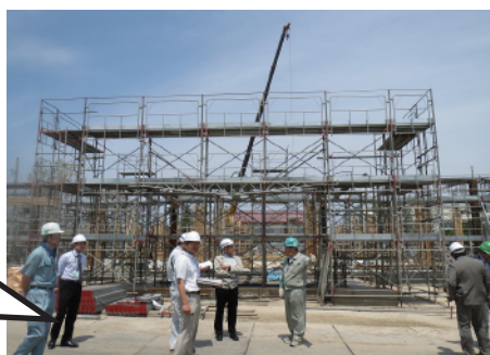
▲新館正面入口の場所にかかる足場
