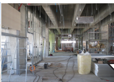
▲南側から見たエントランスの一部
