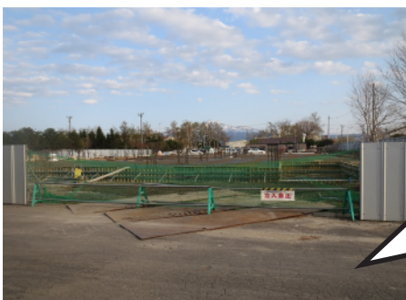
▲斜里中学校米沢通り側出入口から
