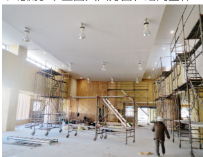
▼北側より正面入口方面、館内全体
