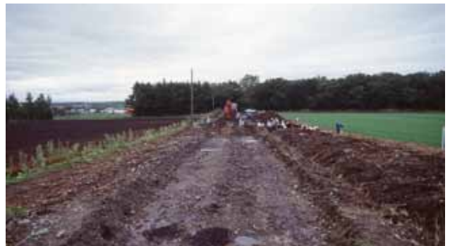
峰浜ポンシュマトカリベツ9遺跡の発掘現場
