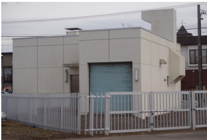
写真3 斜里第4中継ポンプ場
