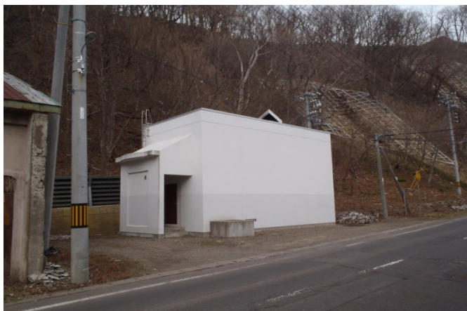
写真2 ウトロ中央ポンプ所発電機室
