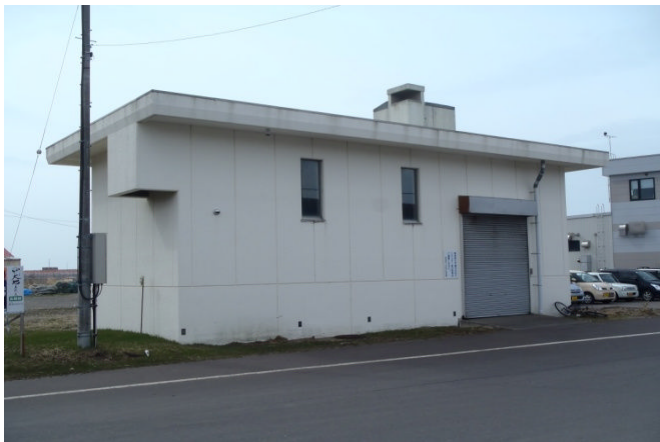
写真2 斜里第2中継ポンプ場
