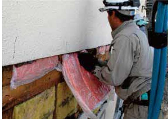
写真8 気流止め材挿入
