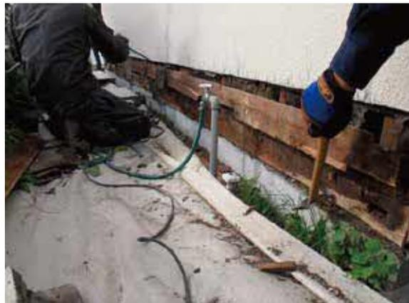
写真7 躯体の打診検査
