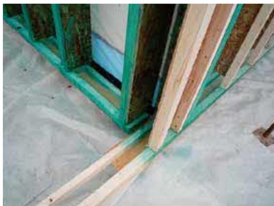
写真20 壁ふかし出隅の施工
