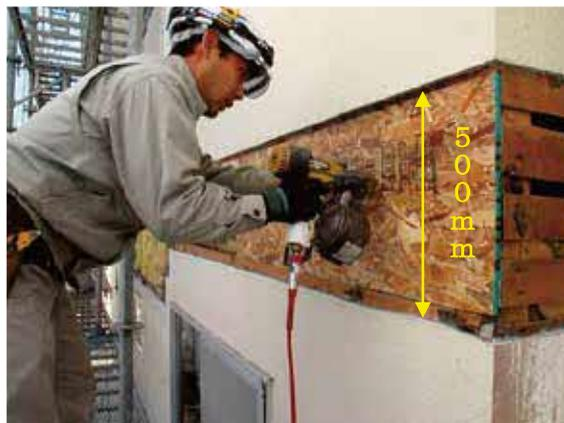
写真11 OSB合板張 桁周り
