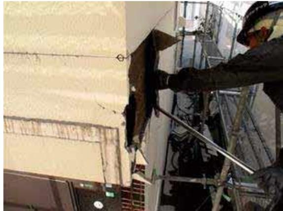
写真5 モルタル撤去桁周り
