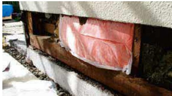
写真9 気流止め材切り込み
