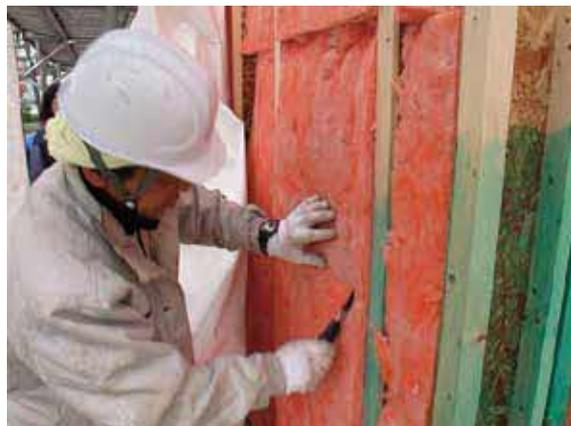
写真 2 3 断熱材の切込み
