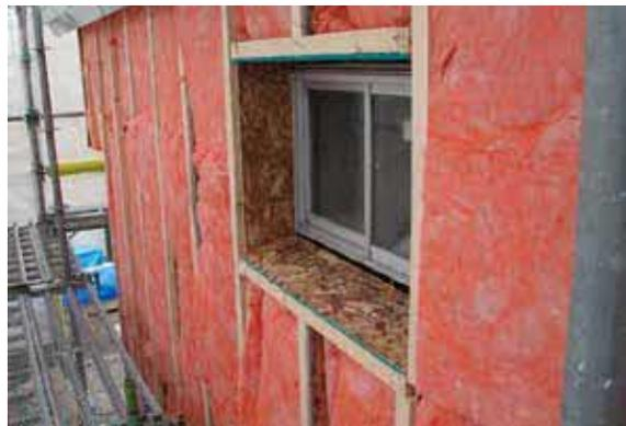
写真 2 2 窓周りの断熱施工
