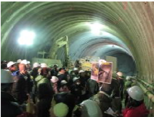
トンネル工事見学会 (1月12日:宇登呂トンネル<仮称>)
