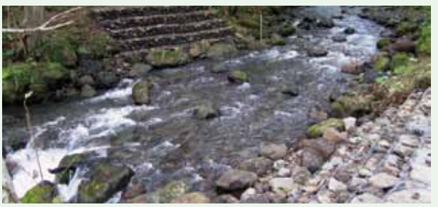
改修前①と改修後②の岩尾別川の河川工作物。ダム段差が解消され、サケやマスが上流まで遊べるようになった。
