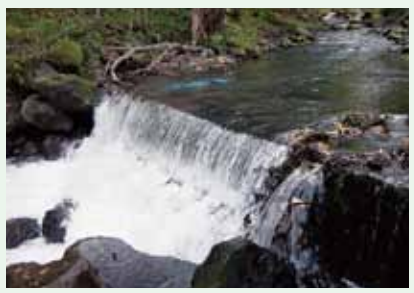
改修前①と改修後②の岩尾別川の河川工作物。ダム段差が解消され、サケやマスが上流まで遊べるようになった。
